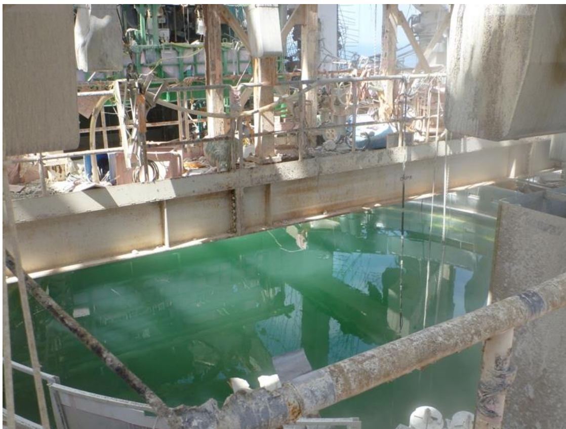
東日本壊滅の危機を救った水が入っていた4号機原子炉建屋5階にある原子炉ウェル＝2011年 6月29日に撮影され、翌30日に東電が公表した写真
