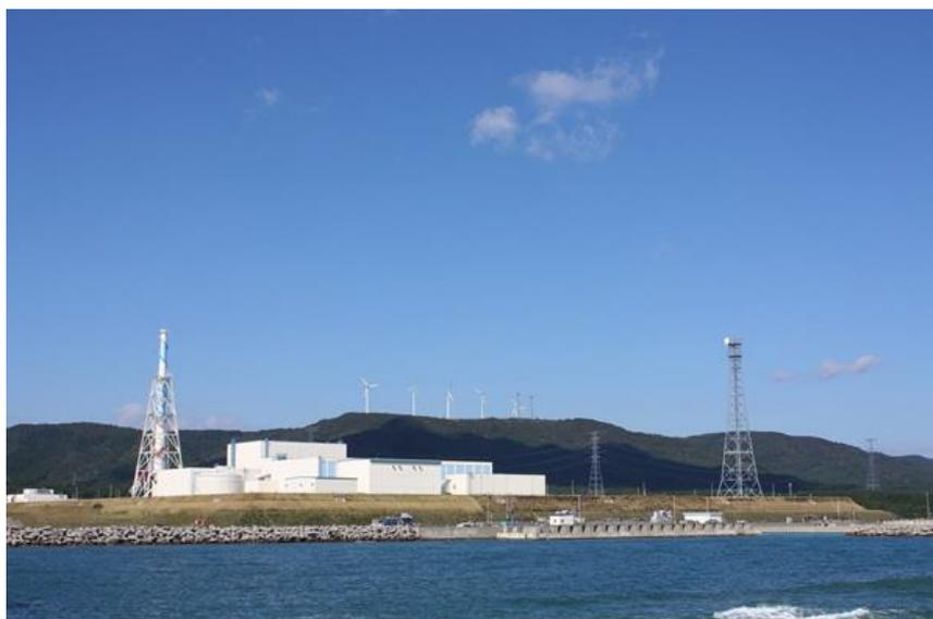
2005 年 12 月 8 日営業運転開始した東通原発 1 号機沸騰水型軽水炉 (BWR) 110 万 kW
