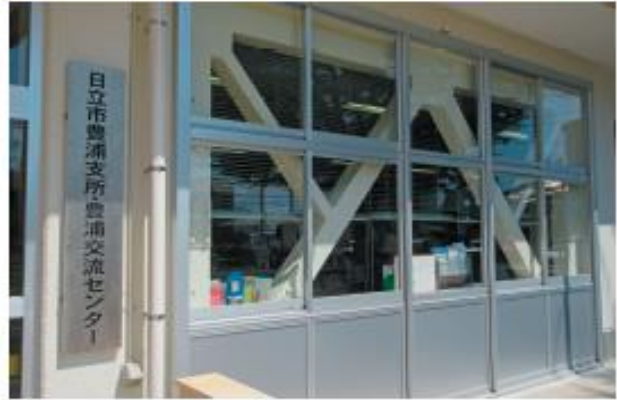
豊浦支所の耐震補強と豊浦交流センター玄関口
