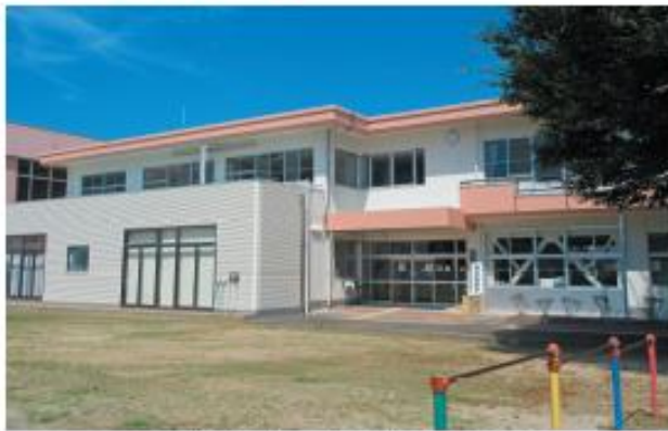
外壁塗装工事でキレイになりました
