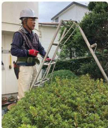
手入れする庭木と三脚とをロープで固定し、安全確保してから作業に着手する作業員
