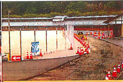
4月中旬アプローチ道も一部舗装整備され4月末には駐車場も完備
