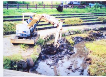
(重機を使用しての整備作業)
