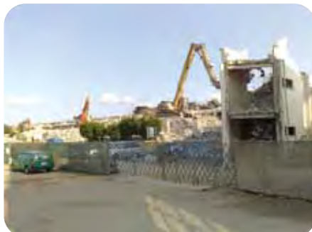
重機を使って解体
