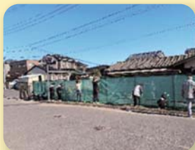
防風ネット補修
