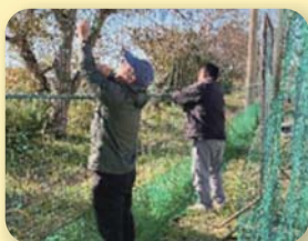
グラウンドネット補修
