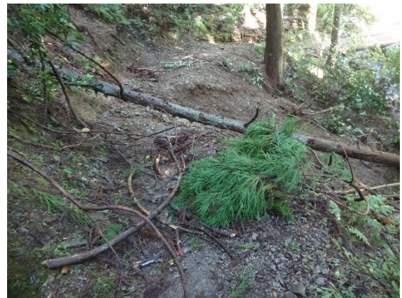
感性トレイル：倒木・歩道崩落
