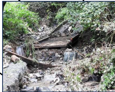
トンネルから最初の橋手前 道路が削れ取られている
