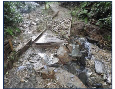
最上流の橋の状況
