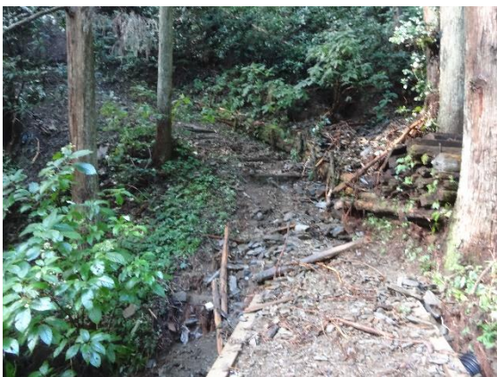
感性トレイル：木橋入口崩落
